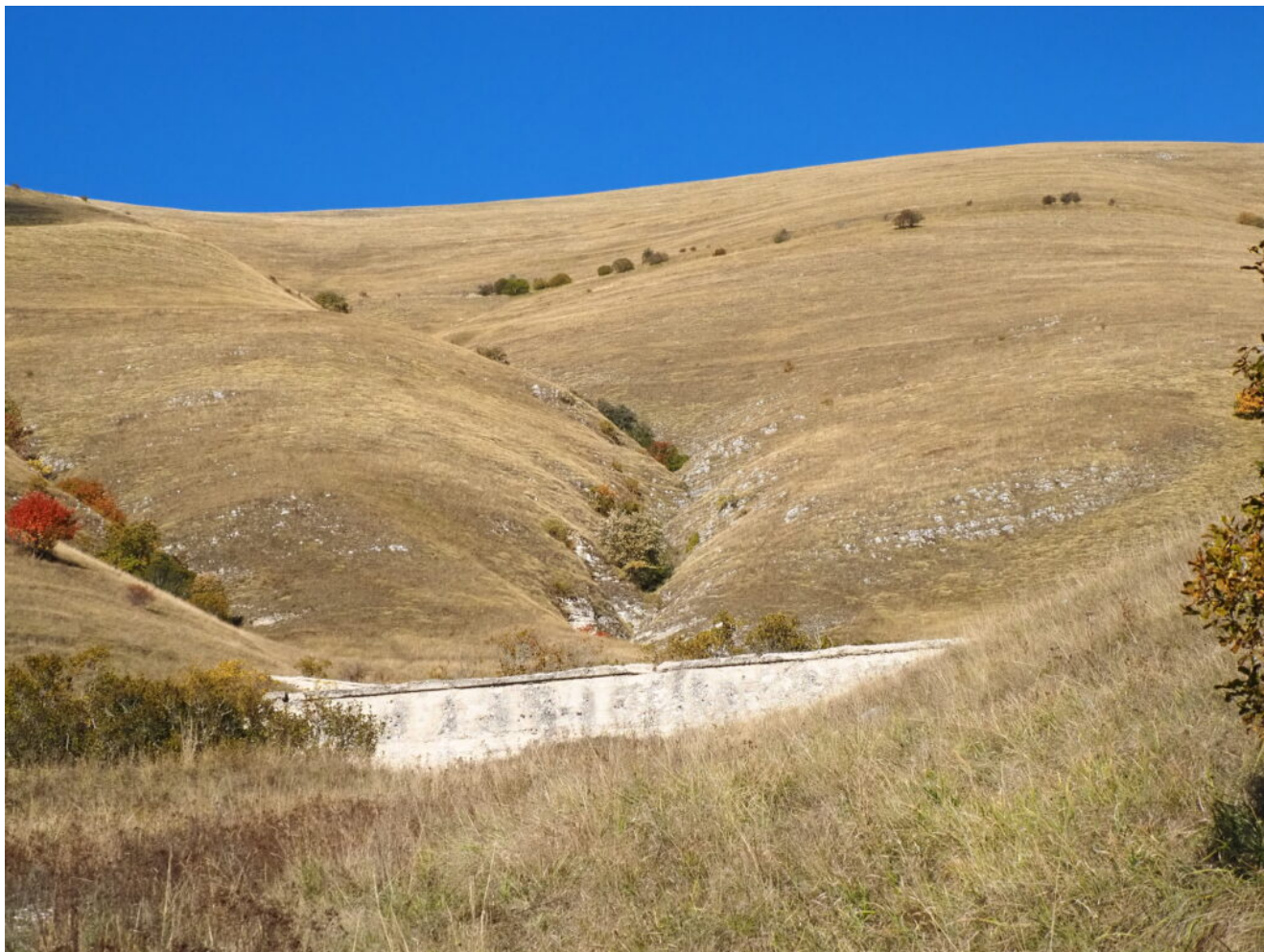
2- Il canale centrale di salita con il primo sbarramento antinondazione in cemento
