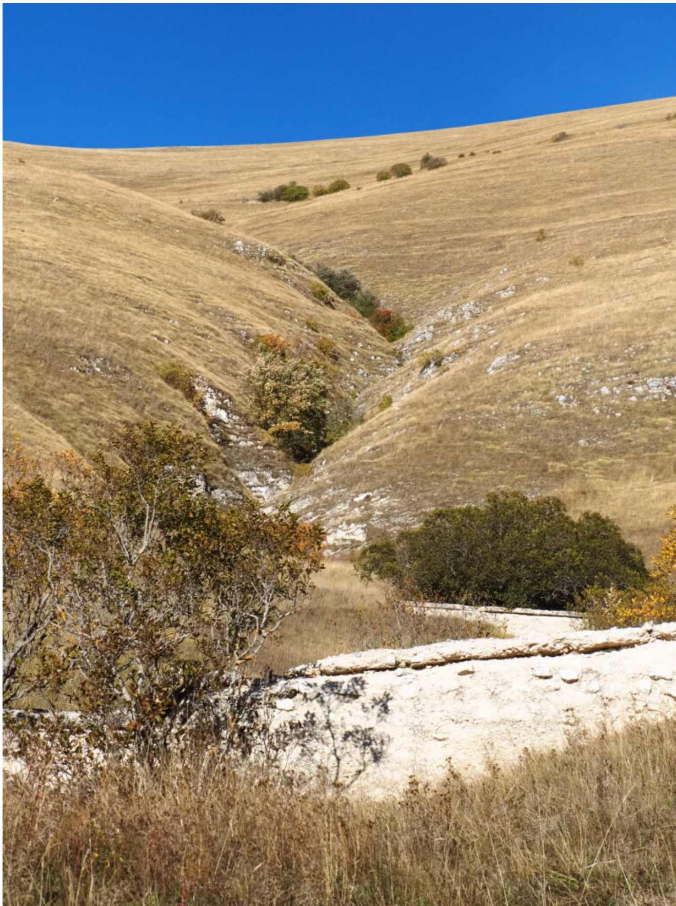
3- Gli altri due sbarramenti in cemento prima del canale di salita.
