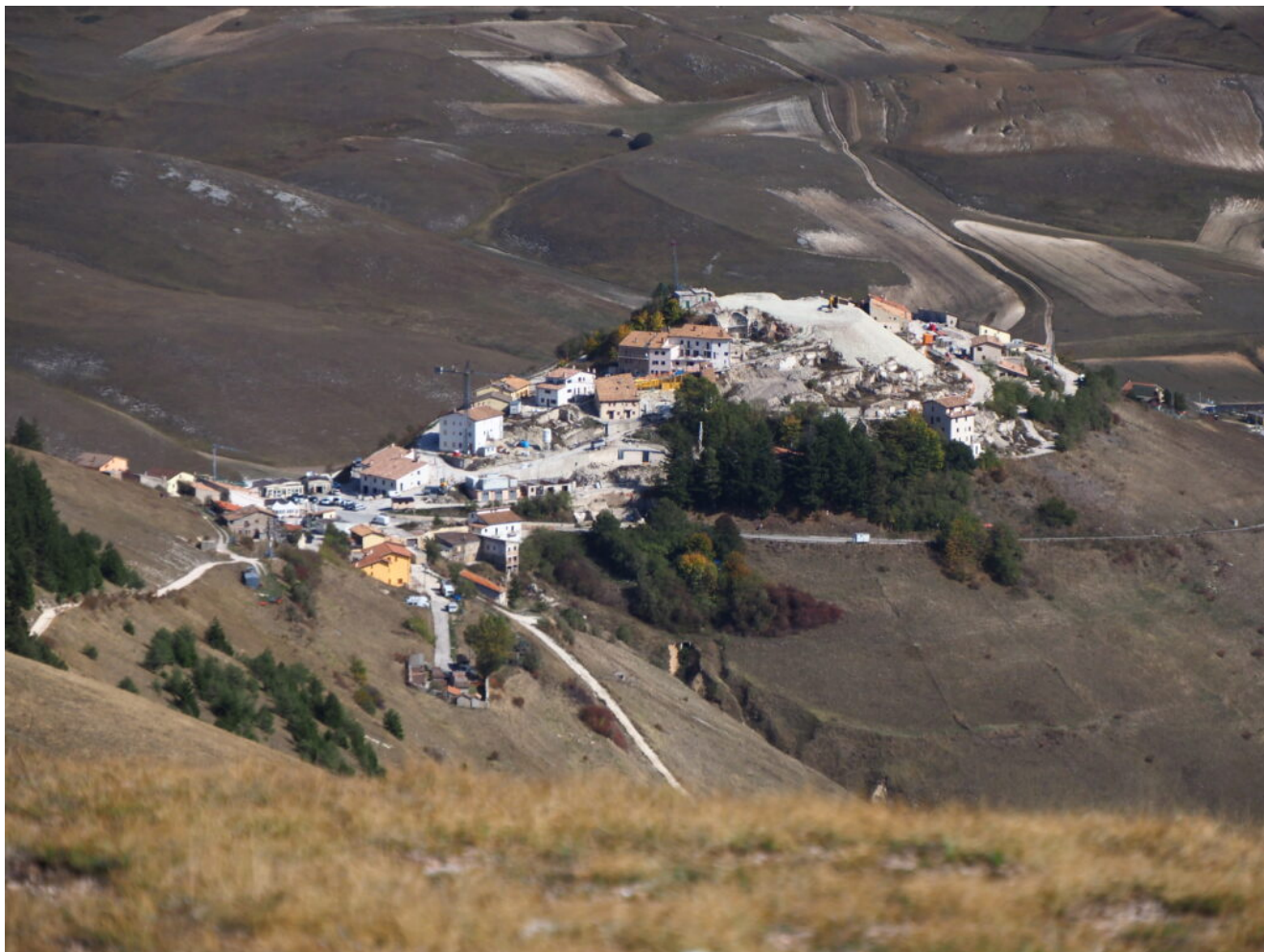
47- Castelluccio con le macerie delle demolizioni nella parte superiore dell'abitato.
