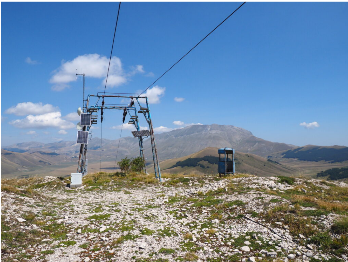
7- I vecchi impianti della cima del Monte Cappelletta, in disuso da anni ed usati di base per ripetitori radio.
