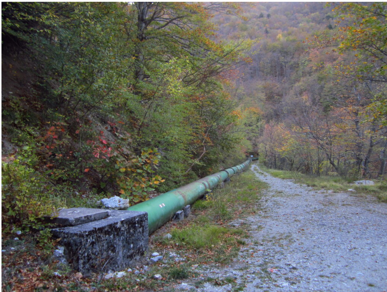
5- Il tratto con il canale metallico
