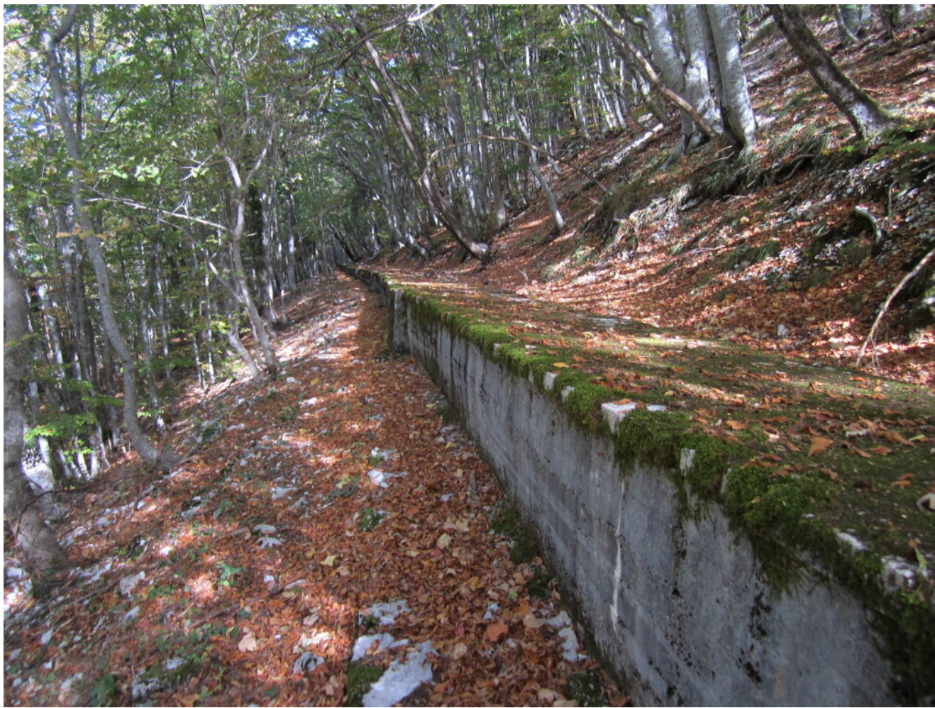
4- Il tratto con il canale in cemento
