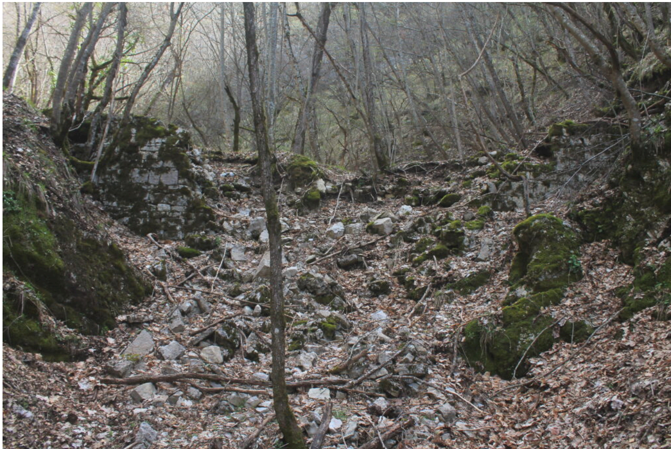
7 – 8- Il muretto di contenimento posto a valle del Fosso di San Chiodo anch'esso in parte crollato.
