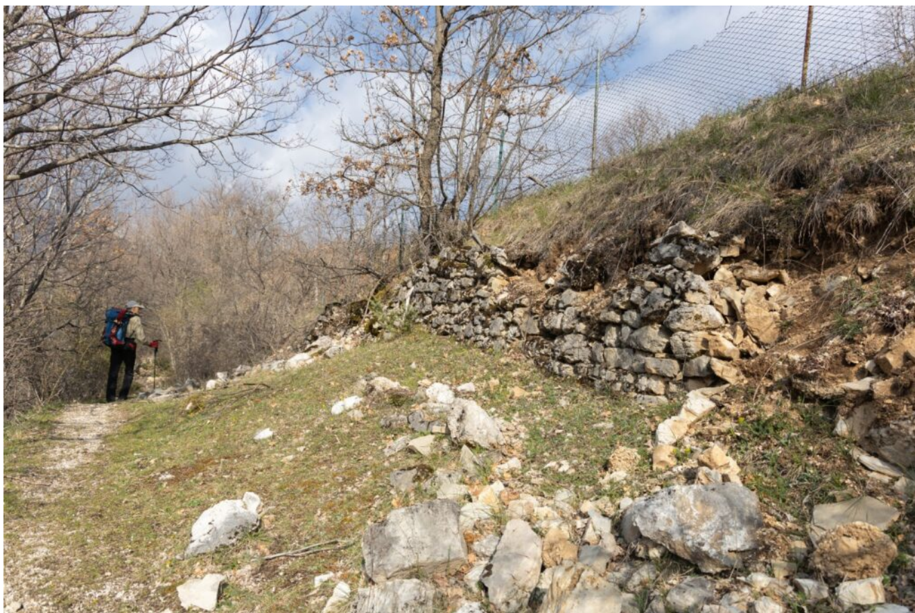
4- Gli antichi muretti a secco, ormai in parte crollati, posti a sostegno del pendio a monte del sentiero.
