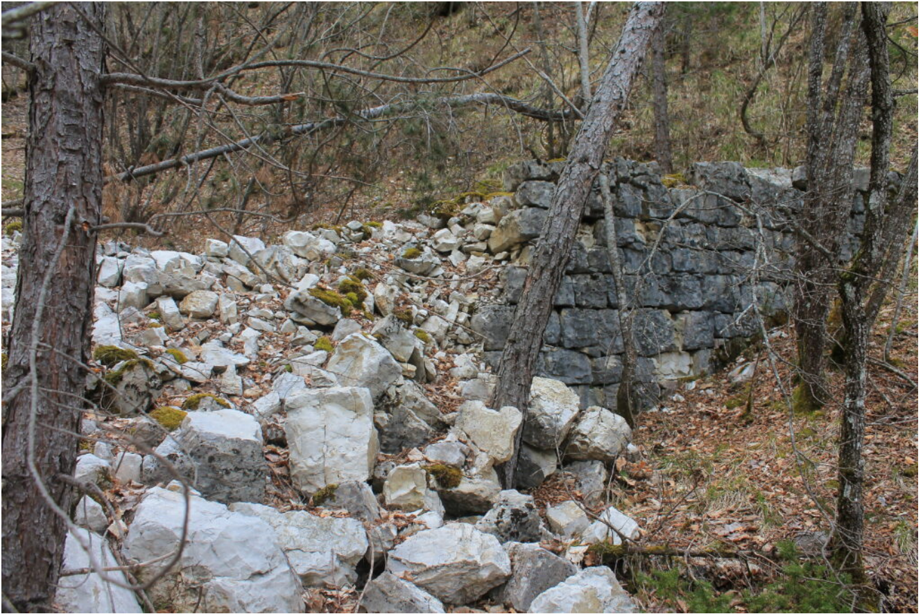
17- Un altro vecchio muretto di contenimento crollato al Fosso di Sant'Angelo
