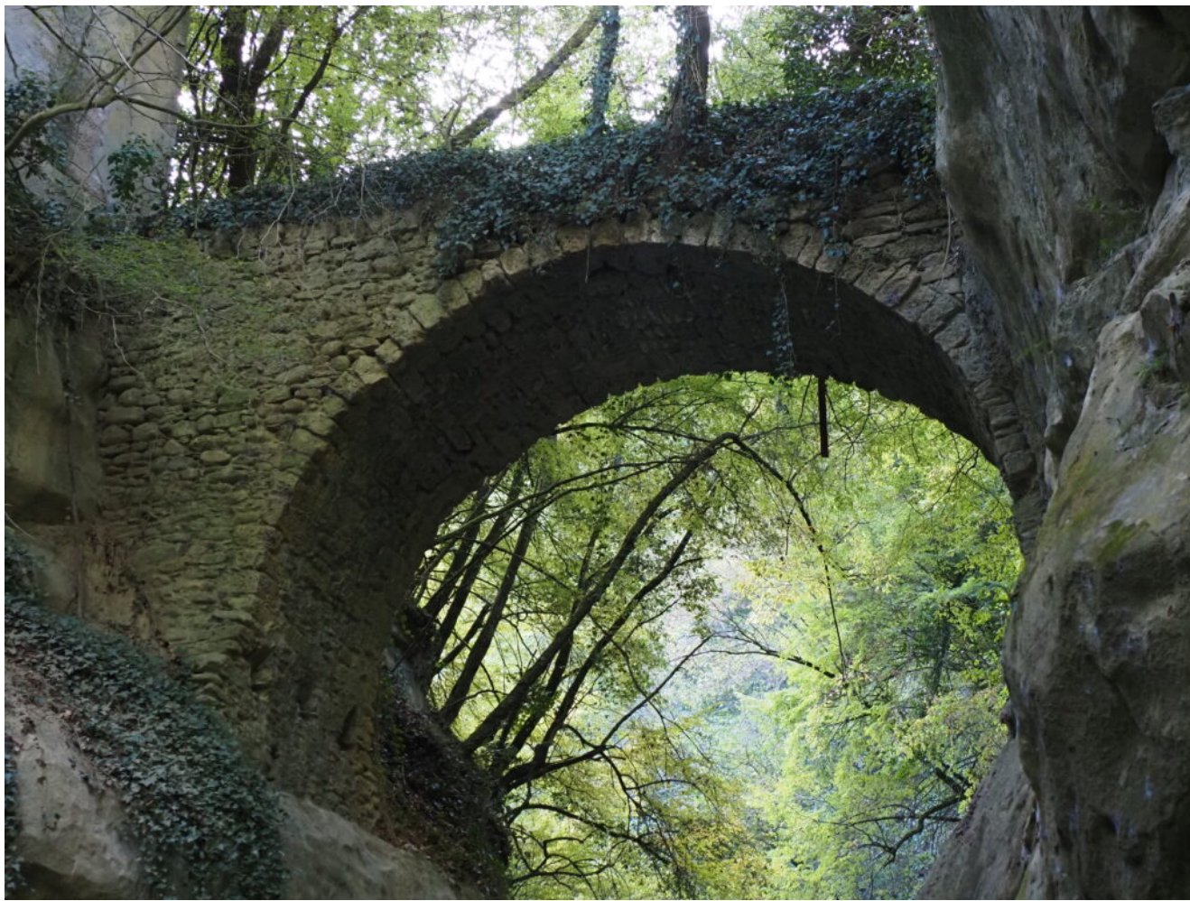
52 – 53 – Dettaglio architettonico del Ponte Romano.
