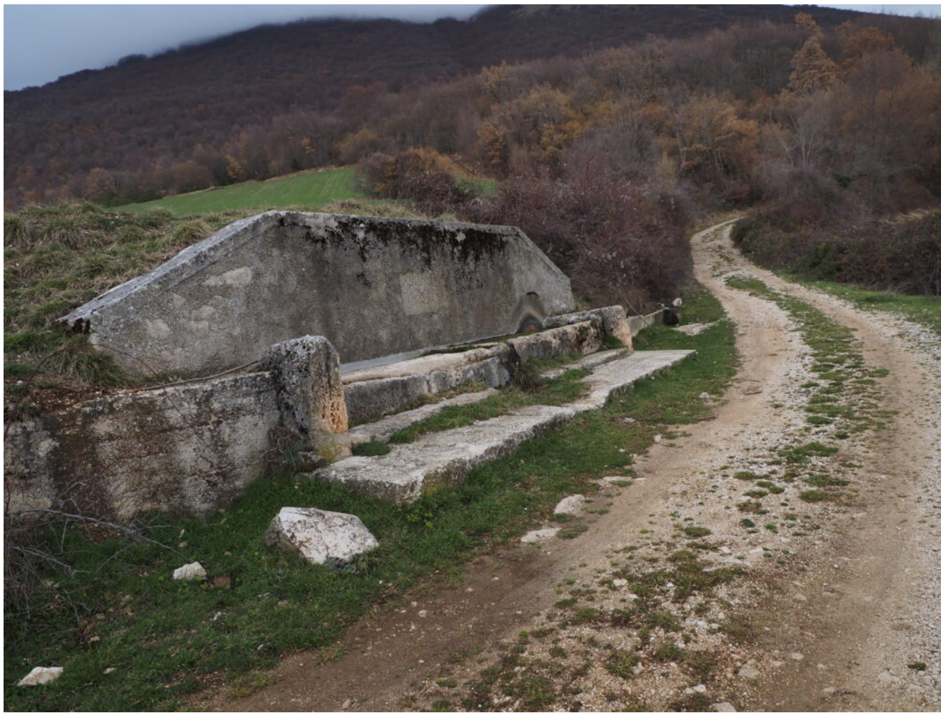
1- La fonte presente all'imbocco del tratturo
