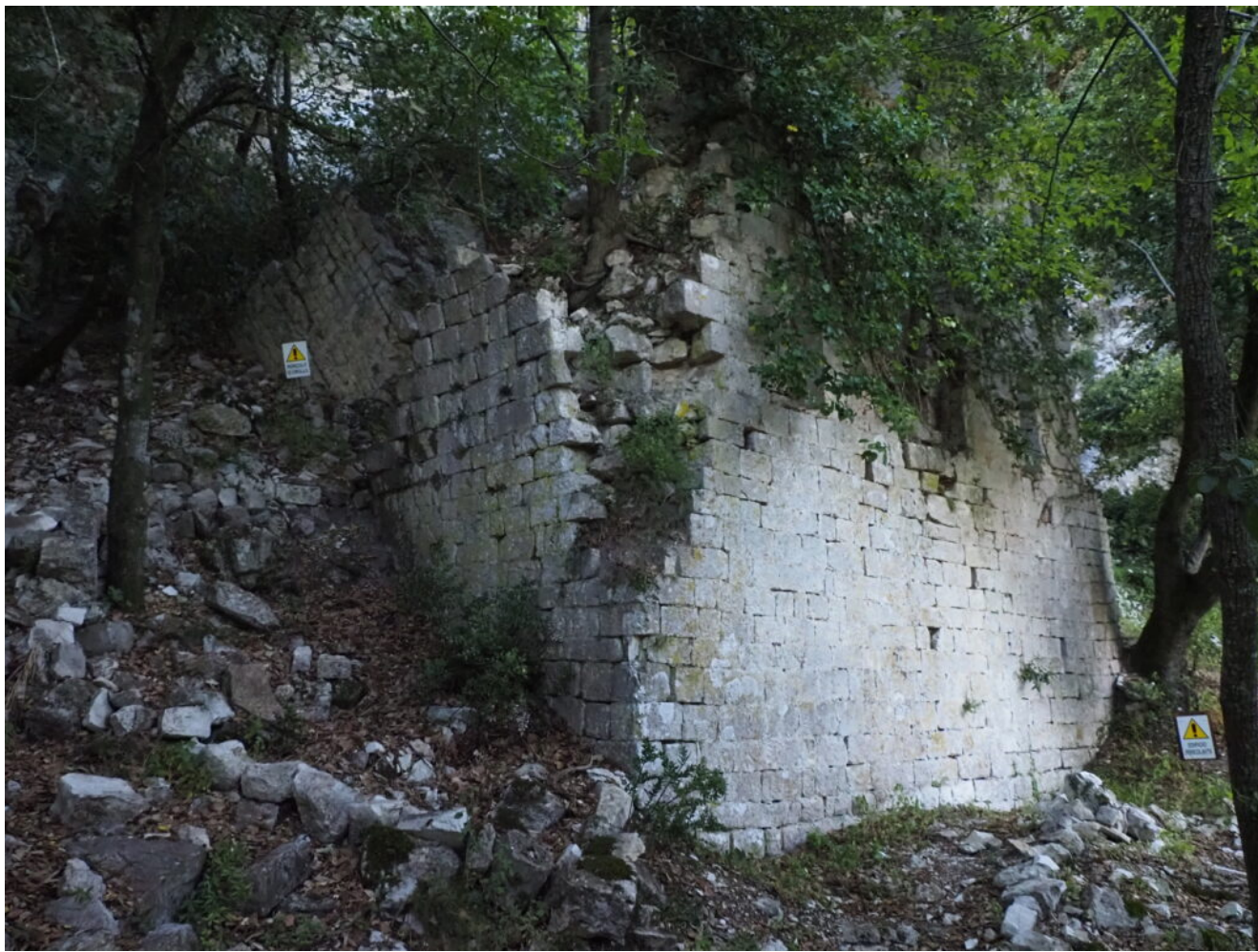
19 – 21 -I ruderi addossati alla parete rocciosa.
