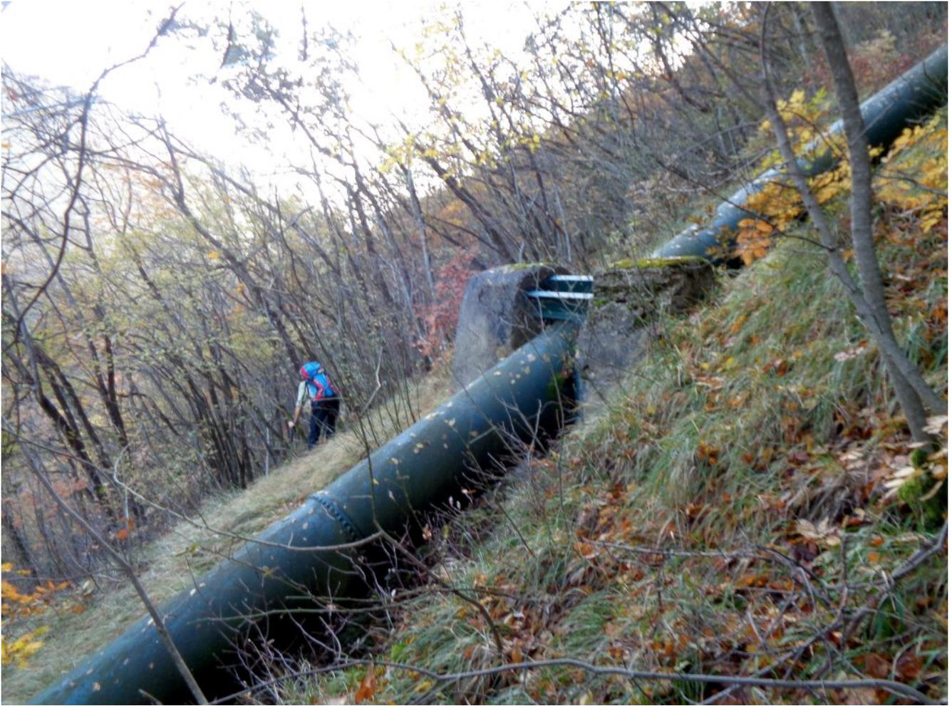
1- La condotta forzata all'altezza dell'11° tornante con il blocco di cemento che permette di superarla per andare nel bosco del versante opposto.
