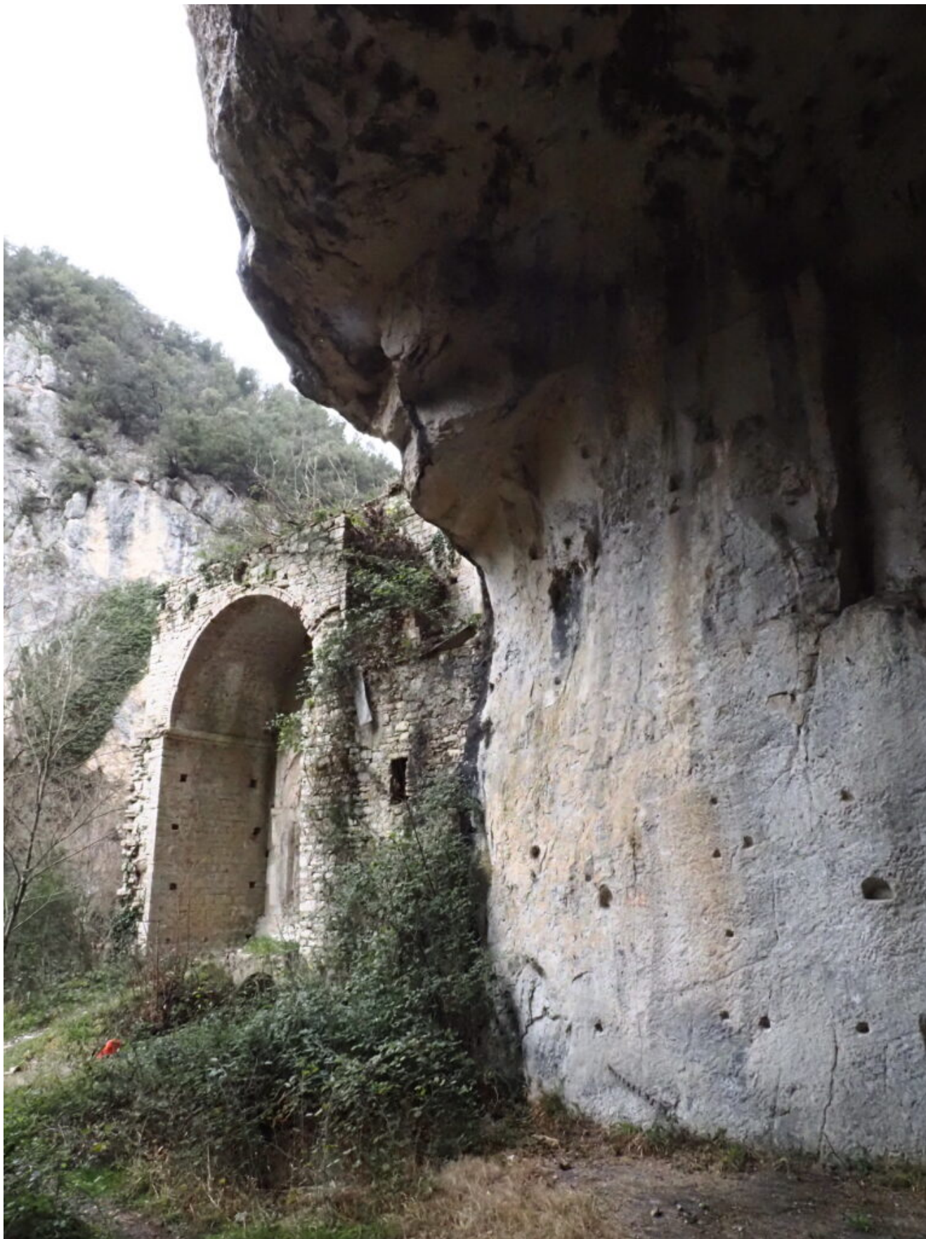
9- L'Eremo visto dalla grotta adiacente.
