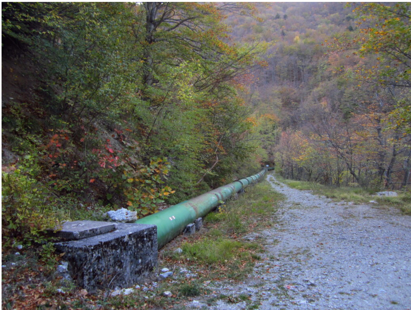
5- Il tratto con il canale metallico
