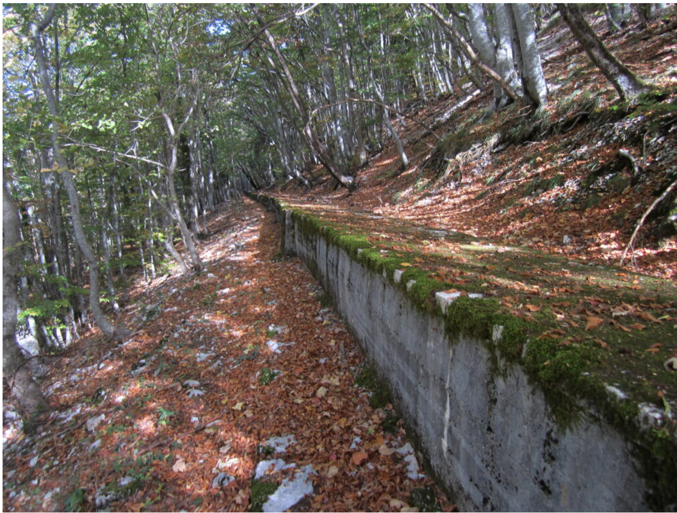
4- Il tratto con il canale in cemento
